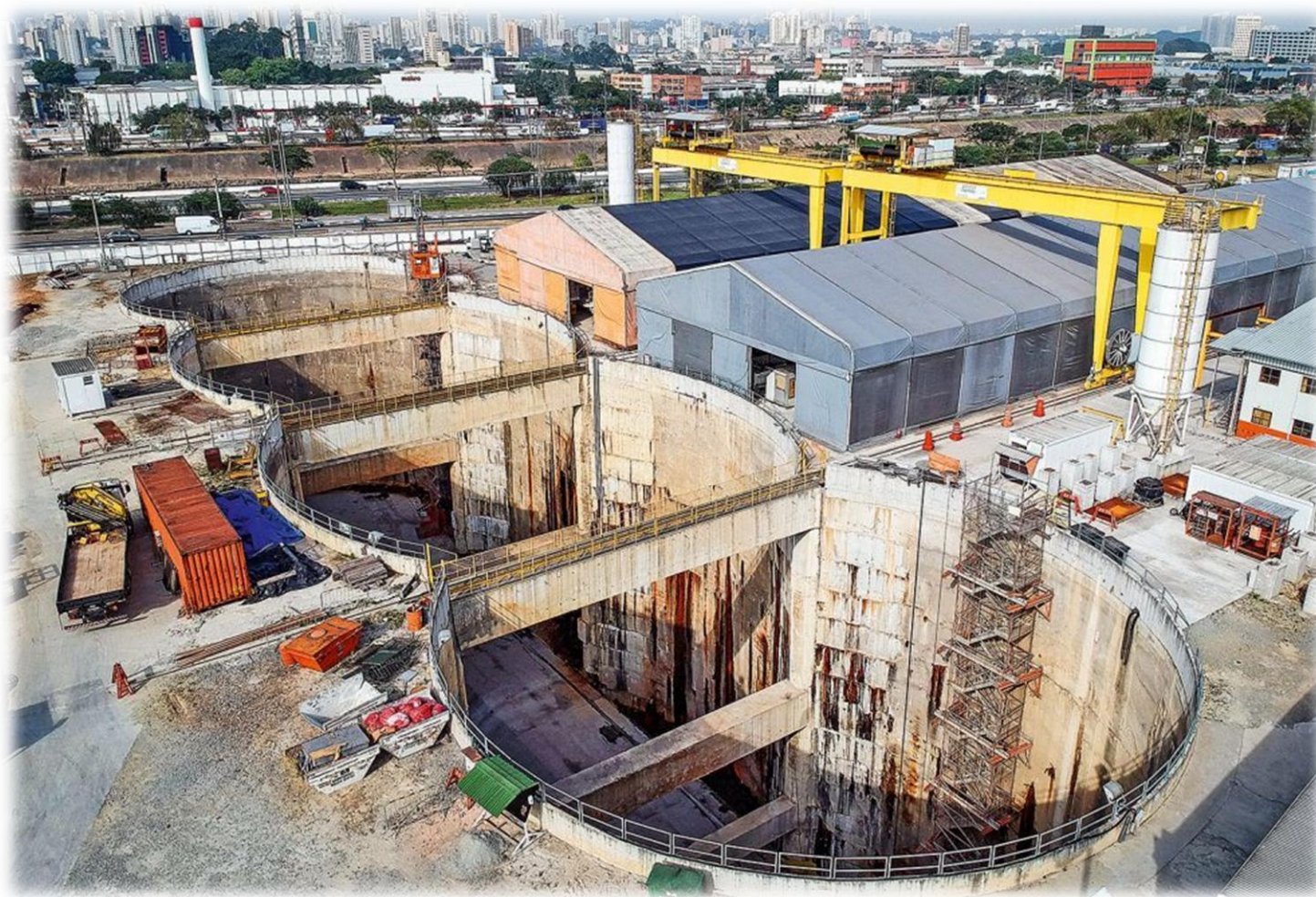
Obras da Linha 6-Laranja
